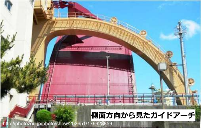
稼働中の安治川水門
