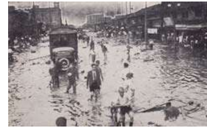
第2室戸台風による浸水被害
