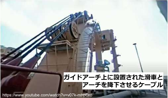
側面方向から見たガイドアーチ
