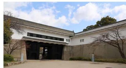
大阪城大手門桁形内部
