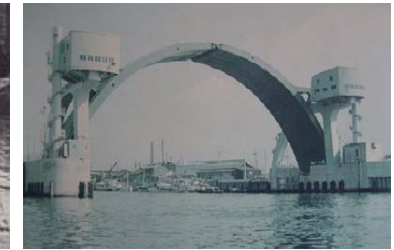
安治川水門建設当初の写真
