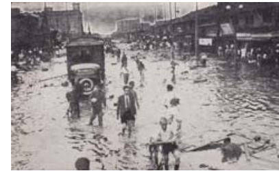
第2室戸台風による浸水被害
